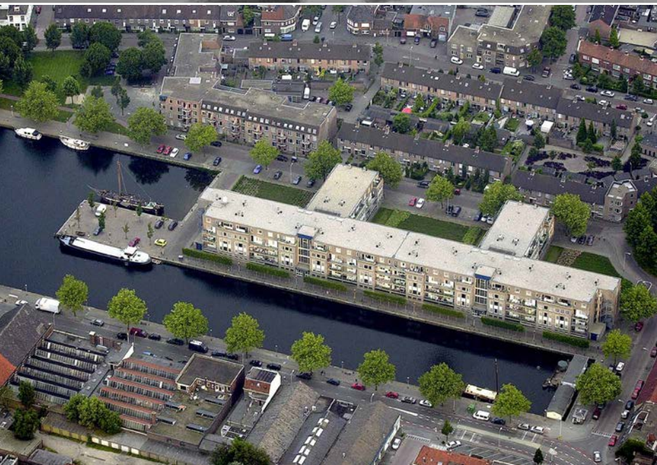
← ± 2005 > Na het dichtgooien van het grootste deel van de zuidelijke havenarm, is de middenpier bebouwd. De kademuur is op sommige plekken in het maaveld nog terug te vinden. Op de kop van de noordelijke havenarm liggen hier nog twee woonarken. Aan de middenpier de eerste twee schepen van de Museumhaven.
