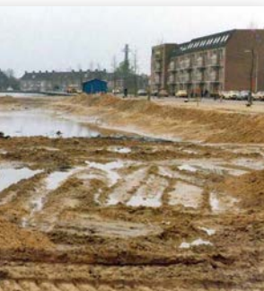
← Demping van de zuidelijke havenarm, 1983
